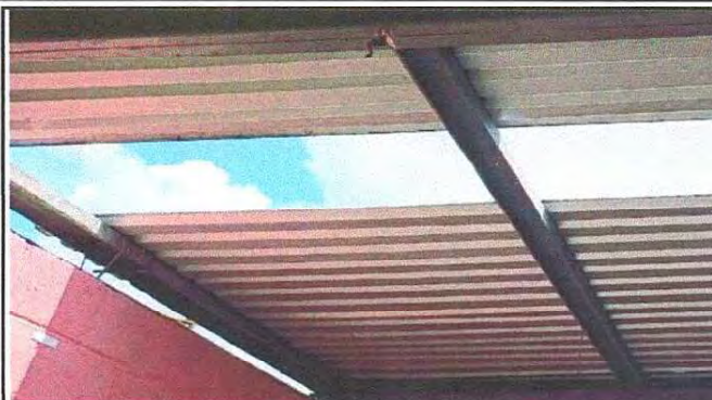
Foto 2: Cambio de cubierta de lámina, se procede a retirar las láminas que están en mal estado. Para instalar las nuevas láminas.
