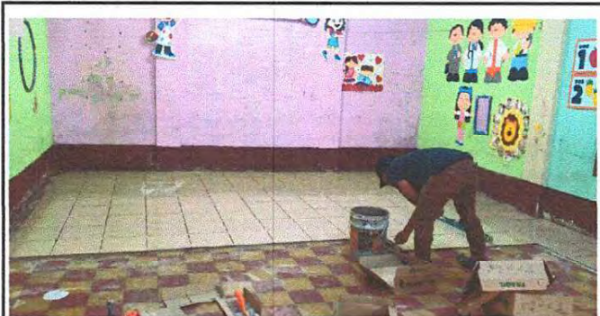
Foto7: Piso, instalación de piso cerámico en el aula dos del primer nivel de la escuela.
