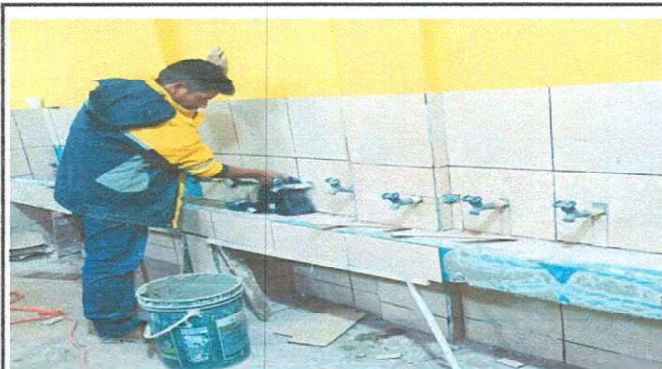
Foto13: Servicios Sanitarios y Accesorios, instalación de cerámico en lavamanos y paredes de los sanitarios del primer nivel de la escuela.
