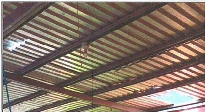
Foto 1: Cambio de cubierta de lámina, se procede a colocar las nuevas láminas troqueladas calibre 26 de 12 pies.
