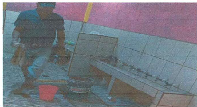
Foto 14: Servicios Sanitarios y Accesorios, instalación de cerámico en lavamanos y paredes de los sanitarios del segundo nivel de la escuela.
