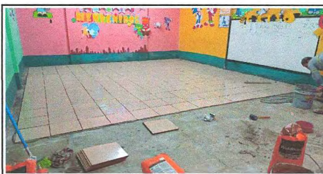
Foto 6: Piso, instalación de piso cerámico en el aula uno del primer nivel de la escuela.
