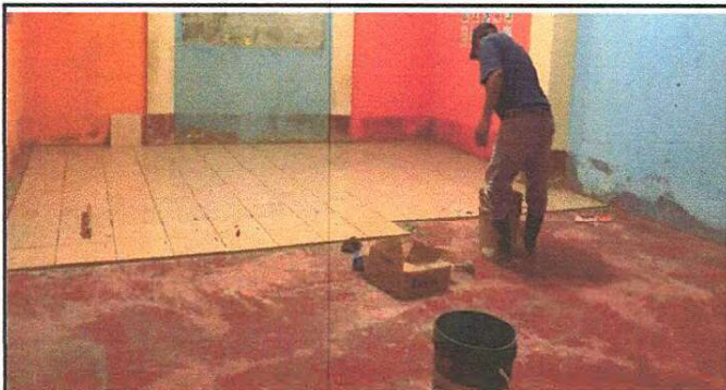
Foto 9: Piso, instalación de piso cerámico en el aula cuatro del primer nivel de la escuela.
