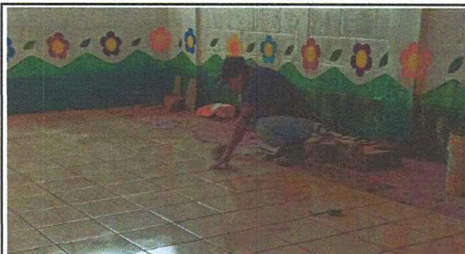
Foto 10: Piso, instalación de piso cerámico en el aula cinco del primer nivel de la escuela.
