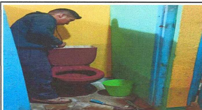
Foto 12: Servicios Sanitarios y Accesorios, cambio de seis inodoros de los servicios sanitarios de la escuela, que se encuentran en el primer nivel de la escuela.
