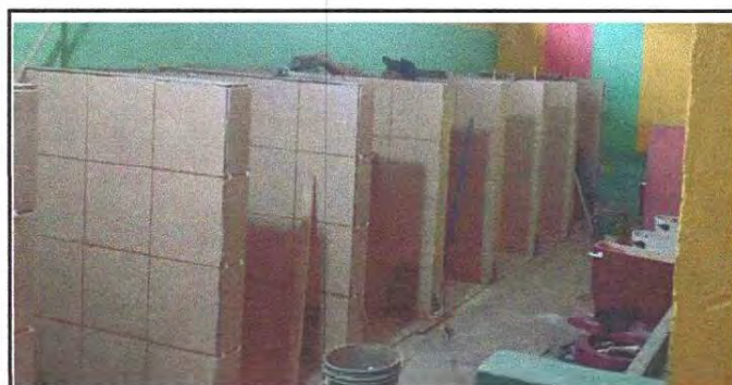
Foto 5: Servicios Sanitarios y Accesorios, instalación de cerámico en los sanitarios del primer nivel de la escuela.
